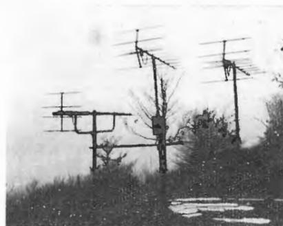
Fig. 3. - Antenne riceventi il canale 8 tcdisco (Feldberg) al di qua delle Alpi, immesso di recente nella rete a cavo coassiale per 600 utenti di Bellinzona. (Gentile concessione Ditta Corneo, Bellinzona).
